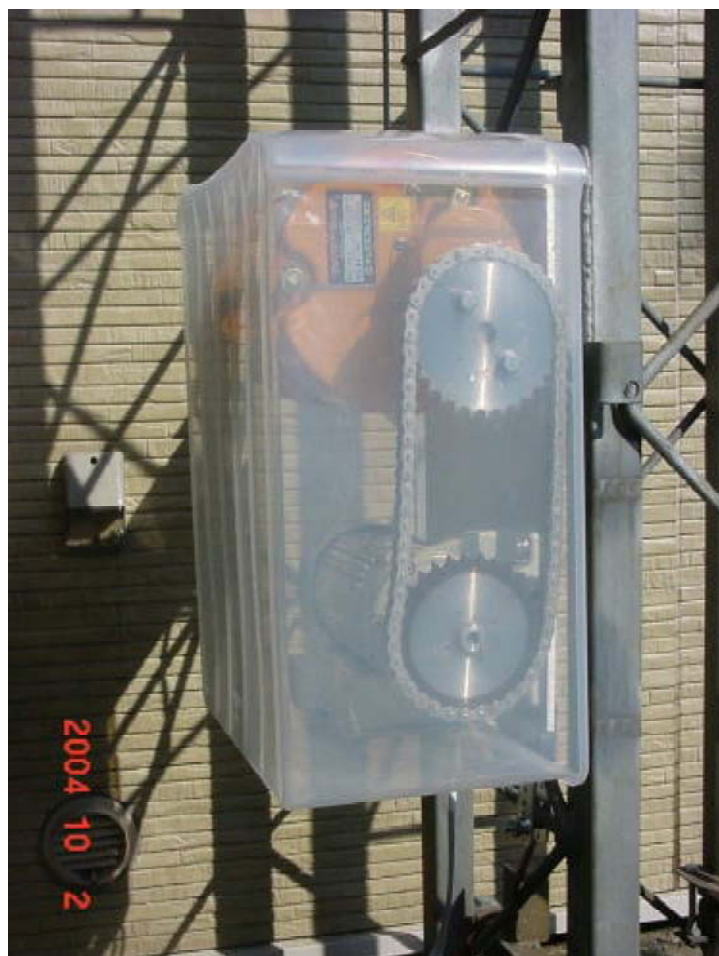
写真9. 押し入れ整理用箱利用の防水カバー
