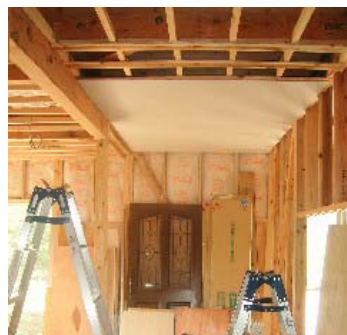
垂木にラス板を取り付けてから化粧版を貼る
