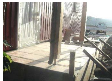
玄関外のタイル工事
