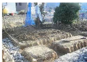
物置基礎工事
