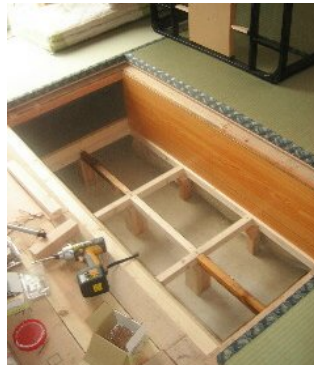
掘りコタツ工事
