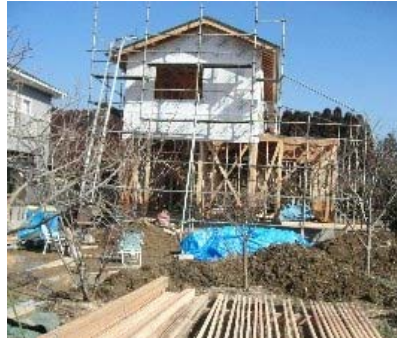
屋根の工事中
