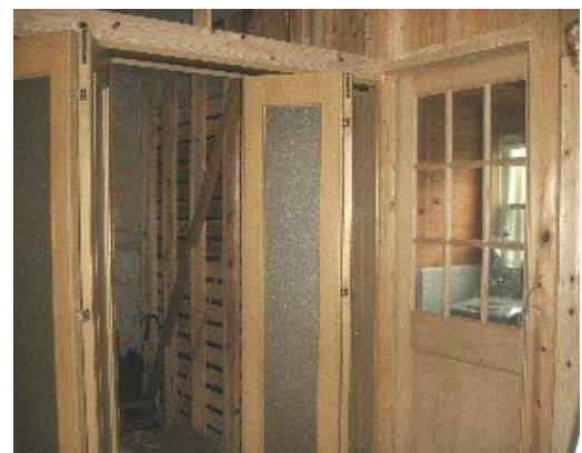
ドアの取り付け作業
