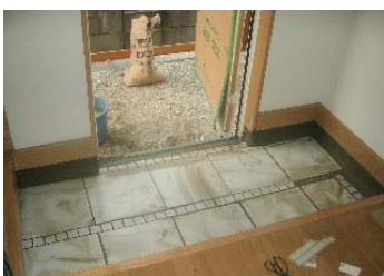
玄関内のタイル工事
