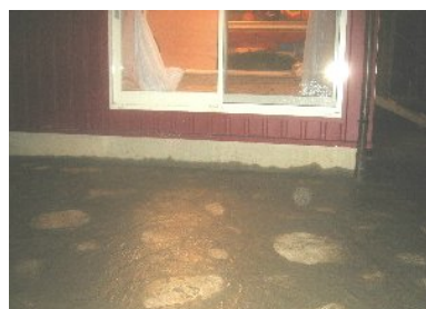
夜半まで工事が続く
