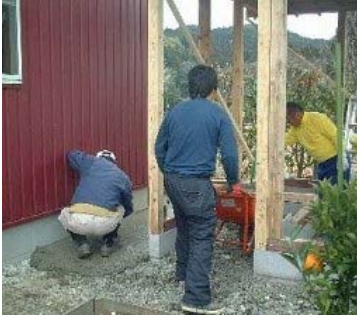
コンクリート打ち開始
