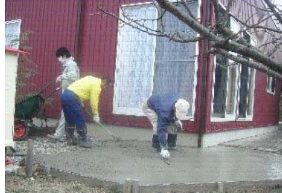
コンクリート打ち工事中
