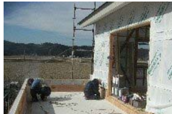
広いベランダの工事も開始
