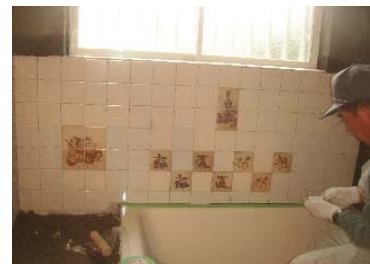
風呂タイル工事中
