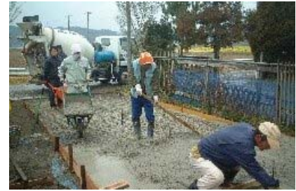
雨の中駐車場コンクリート打ち
