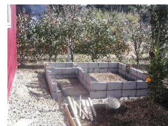
物置ブロック工事
