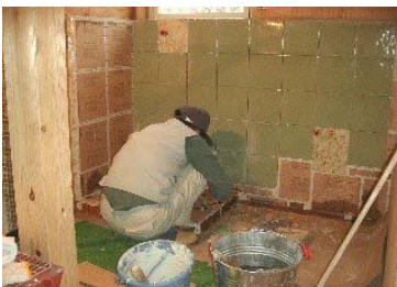
洗濯場もタイルで工事
