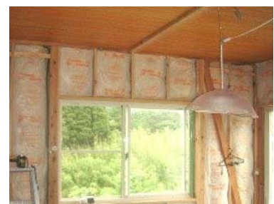
2階和室の天井貼り
