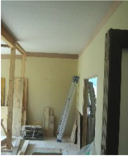
石膏ボード貼り作業
